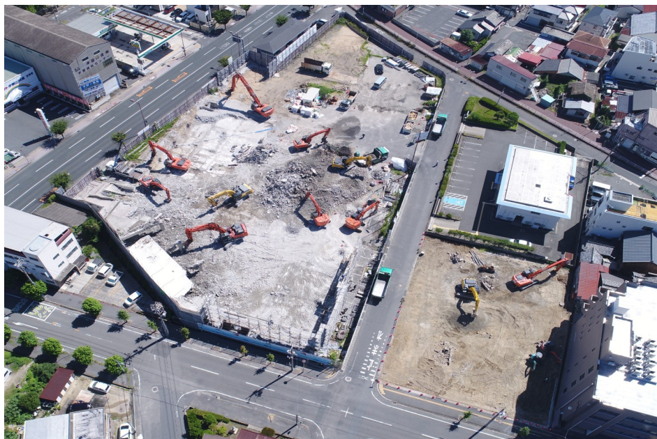
令和4年7月 解体後
